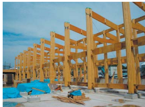
写真2 スギ丸太9本を束ねている束ね柱
