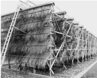
図3 流下式塩田(兵庫県赤穂市)
