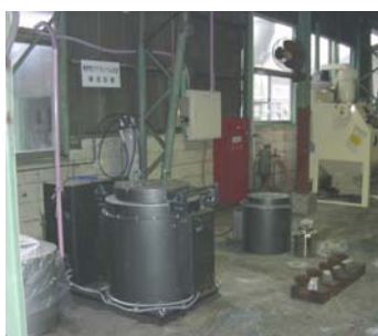
図 5 パイロットプラント
