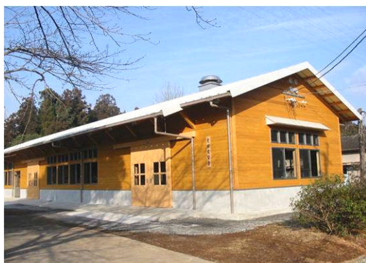
「塗装室」「試験機室」「木工機械室」を有する実験実習舎
