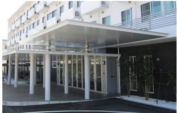
写真.7 アルミハニカムパネルの底の施工例
