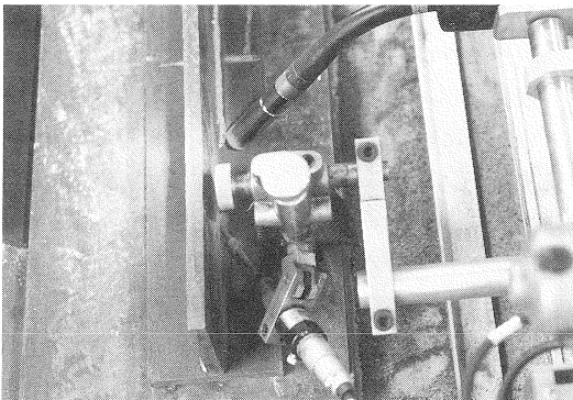
写真3-5 すみ肉溶接におけるトーチ・倣いセンサのセッティング
