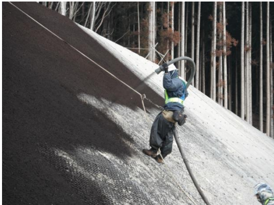
Fig.3 緑化施工試験の様子
