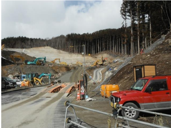
Fig.1 緑化施工試験を行う吉浜エリア付近
