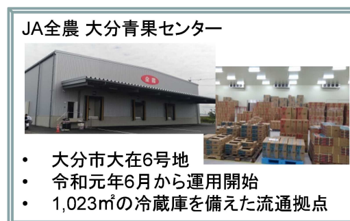
図6 大分市に設置された物流拠点
